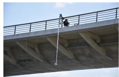
懸垂型点検ロボットカメラによる
